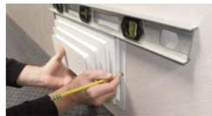
POSITION INTAKE GRILLE AT DESIRED HEIGHT, LEVEL & MARK MOUNTING HOLES ON STUDS.
