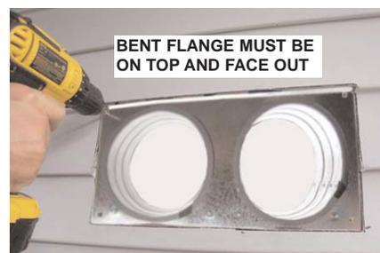
LEVEL HOOD BACKING PLATE AND SECURE TO WALL USING (4) SCREWS. **IMPORTANT:** MAKE SURE BENT FLANGE IS ON TOP FACING OUT.
